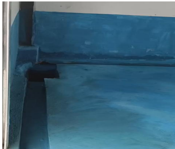
危废间内部地面防渗、导流沟、收集池
