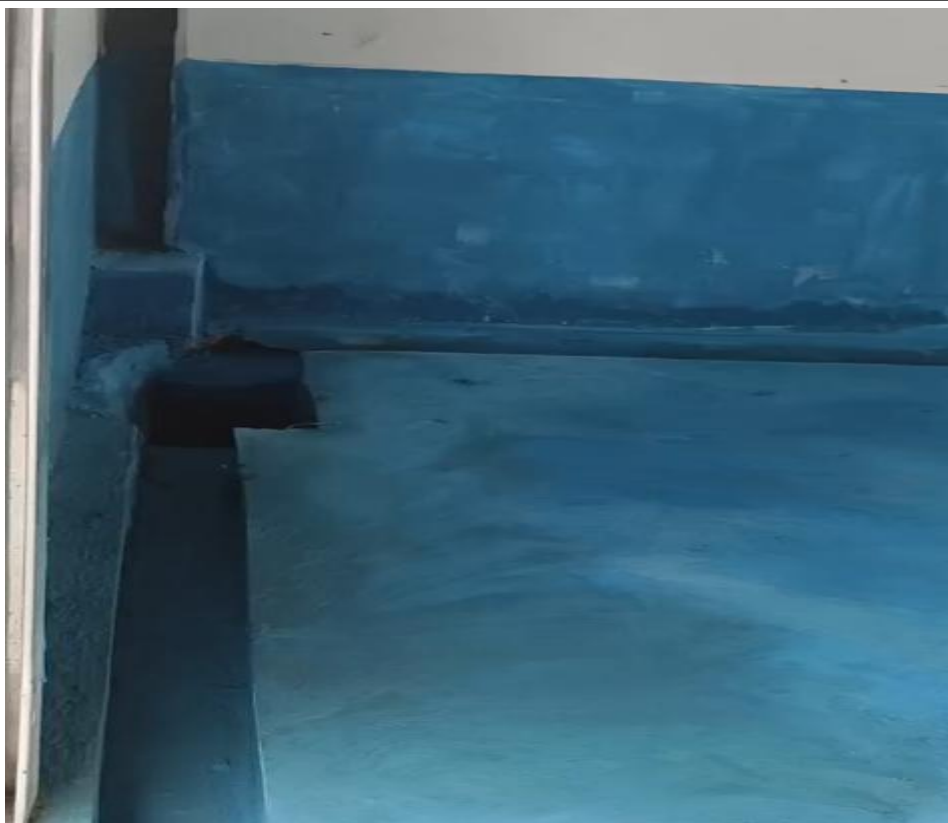
危废暂存间标识牌及内部导流沟、收集沟
