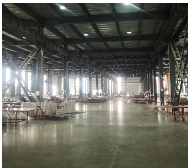
2#车间地面环氧地坪
