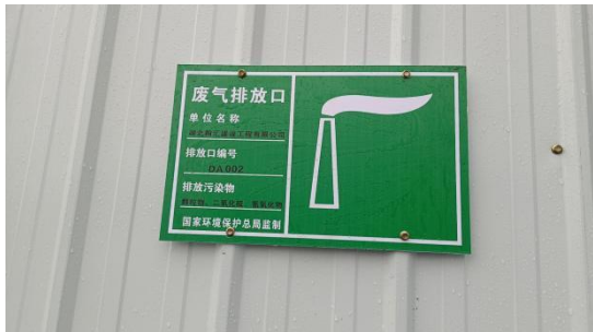
燃烧/烘干废气排放口（DA002）标识牌
