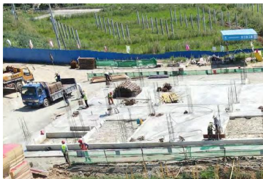
施工期围挡措施
