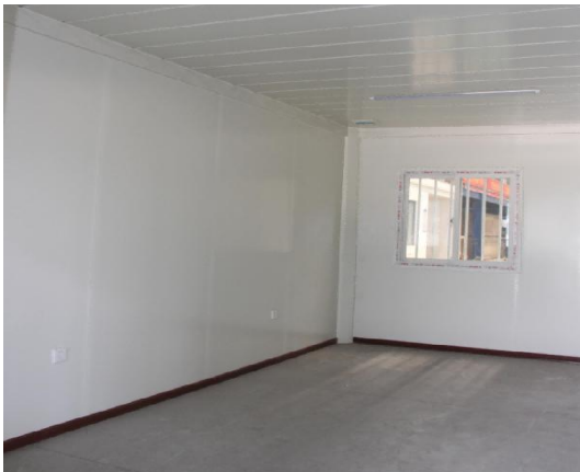
危废暂存间内部防渗措施
