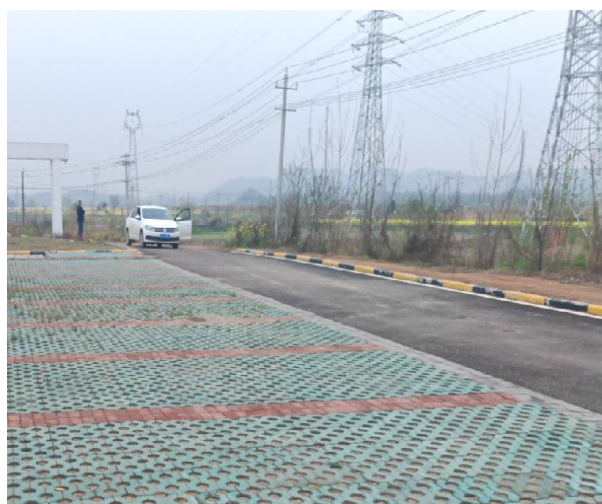
升压站区新建道路（混凝土路面）
