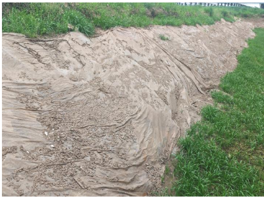
施工期临时苫盖
