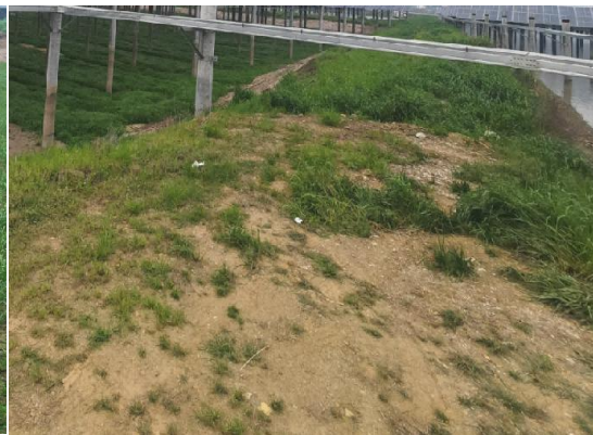
施工期土地平整
