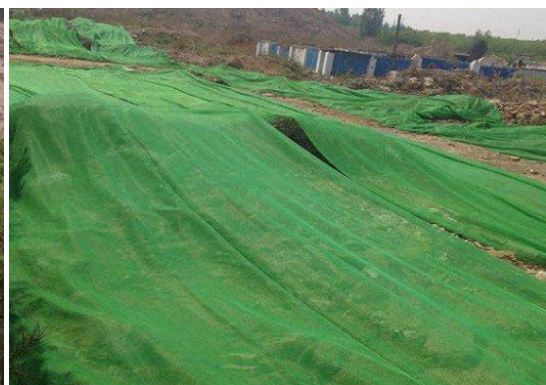
临时苫盖措施
