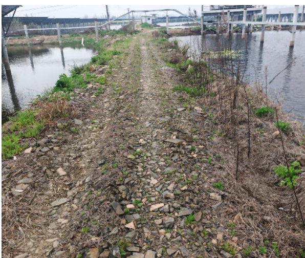
光伏区新建道路（碎石路面）
