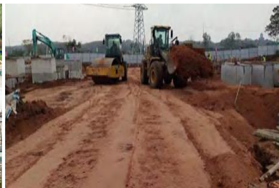
光伏场地电缆区土地恢复施工
