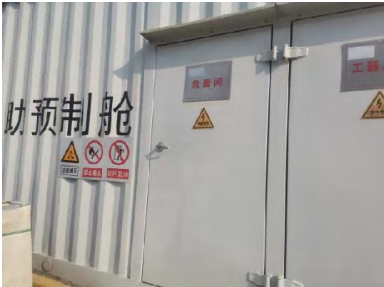
110kV升压站B危废暂存间
