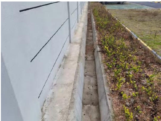
升压站区雨水管沟
