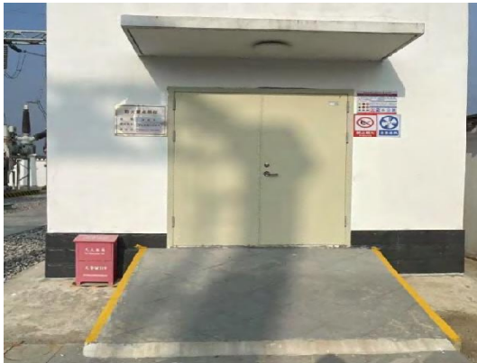
220kV升压站危废暂存间
