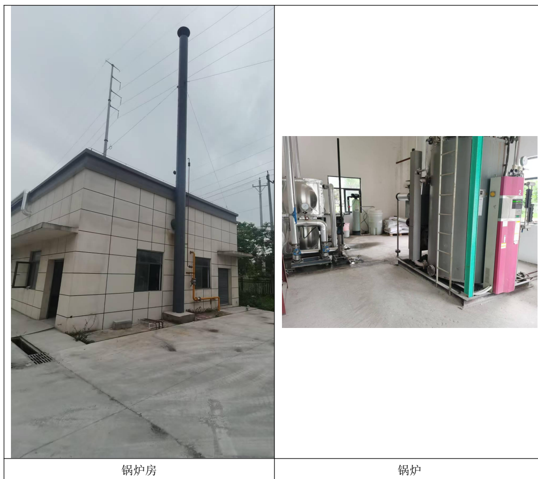
图 2-1 项目现场情况图片
