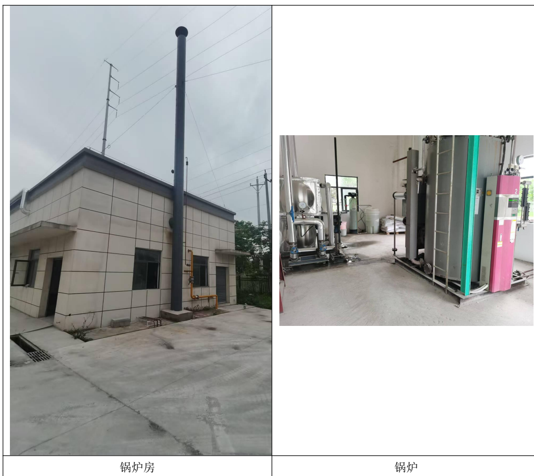
图 2-1 项目现场情况图片
